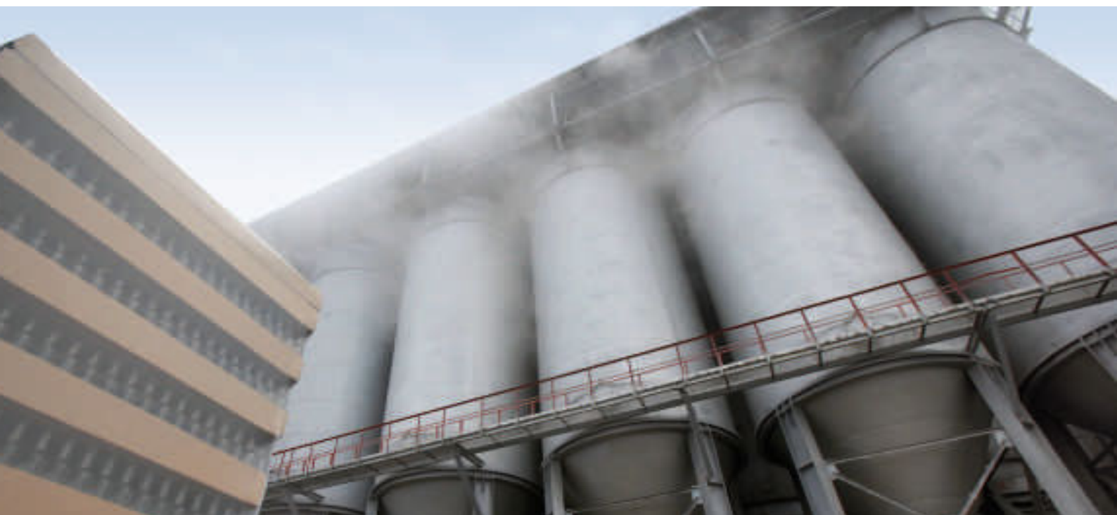
Gemengehaus mit Rohstoffsilos. Die Komponenten werden automatisch für die Glasproduktion dosiert, gewogen und gemischt.
