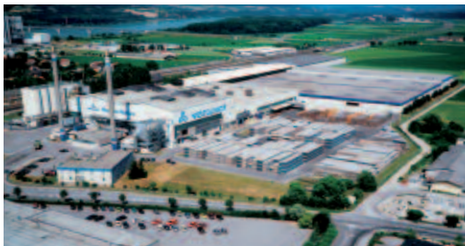
Usine de Pöchlarn (Autriche)
