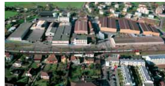
Usine de St-Prex (Suisse)
